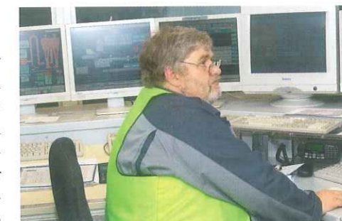
Von der Leitstelle aus wird die vollautomatische Anlage gesteuert und kontrolliert.
